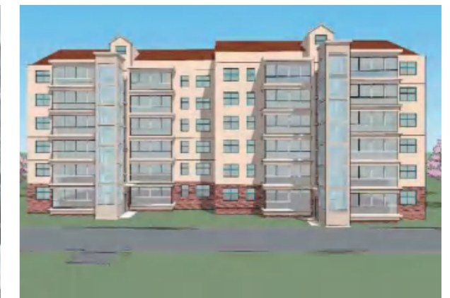
· 公司正在进行的既有住宅加装电梯项目
